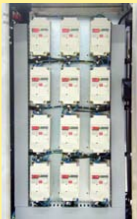
inversores de frequência para o controle de tensão individual de cada fita
